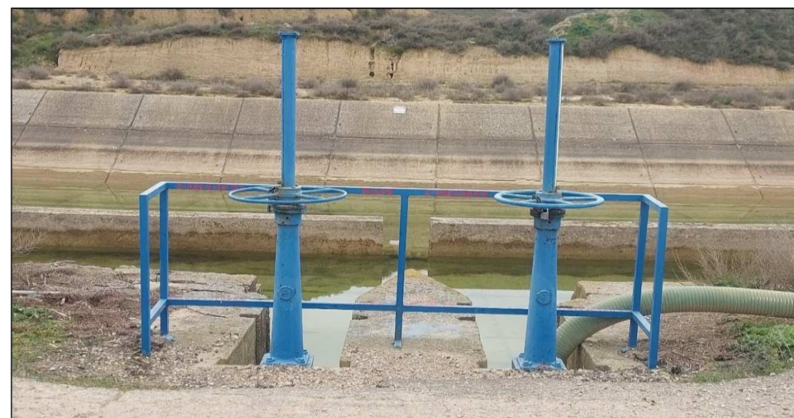
Figura 7. Compuerta actual de la toma lateral M-60,085
