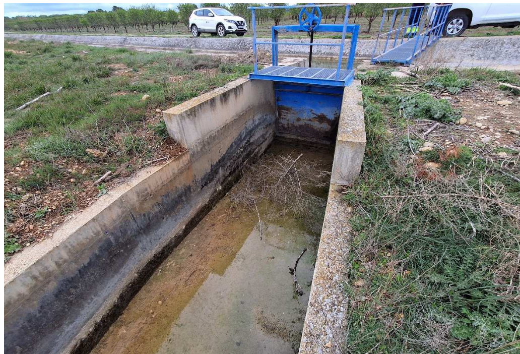
Fotografía 41 Compuerta V-18,088 en la Acequia de La Violada.
