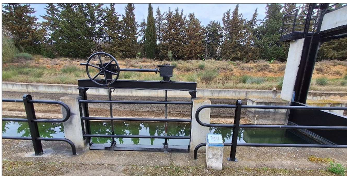
Figura 8. Compuerta actual de la toma lateral P-9,880
