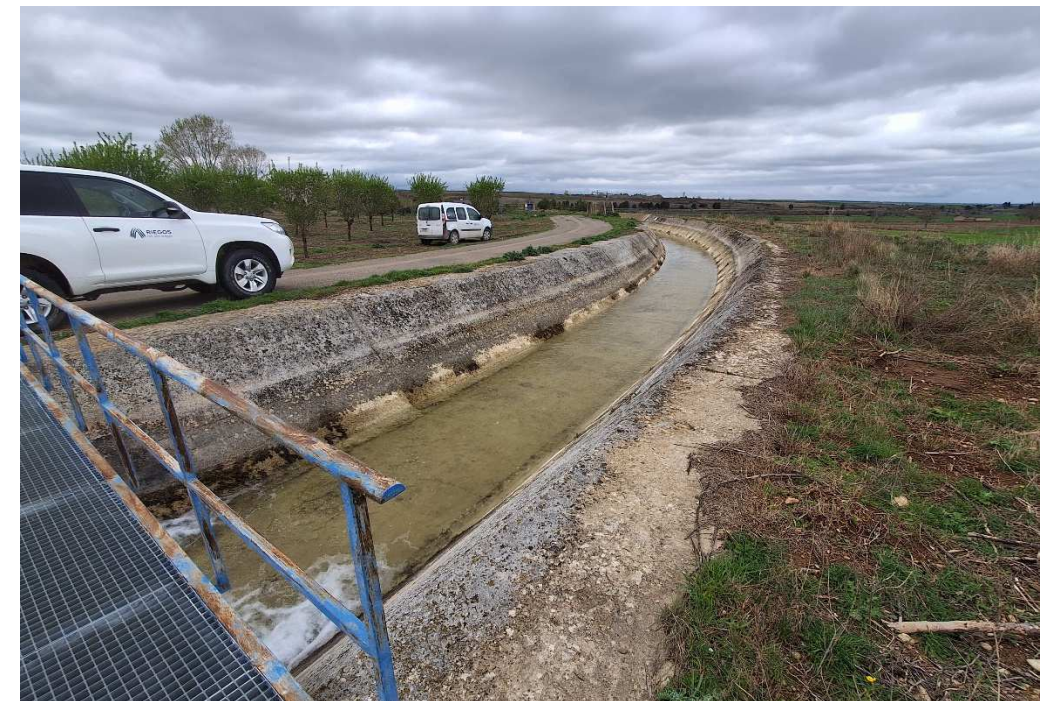
Fotografía 43 Compuerta V-18,088 en la Acequia de La Violada.
