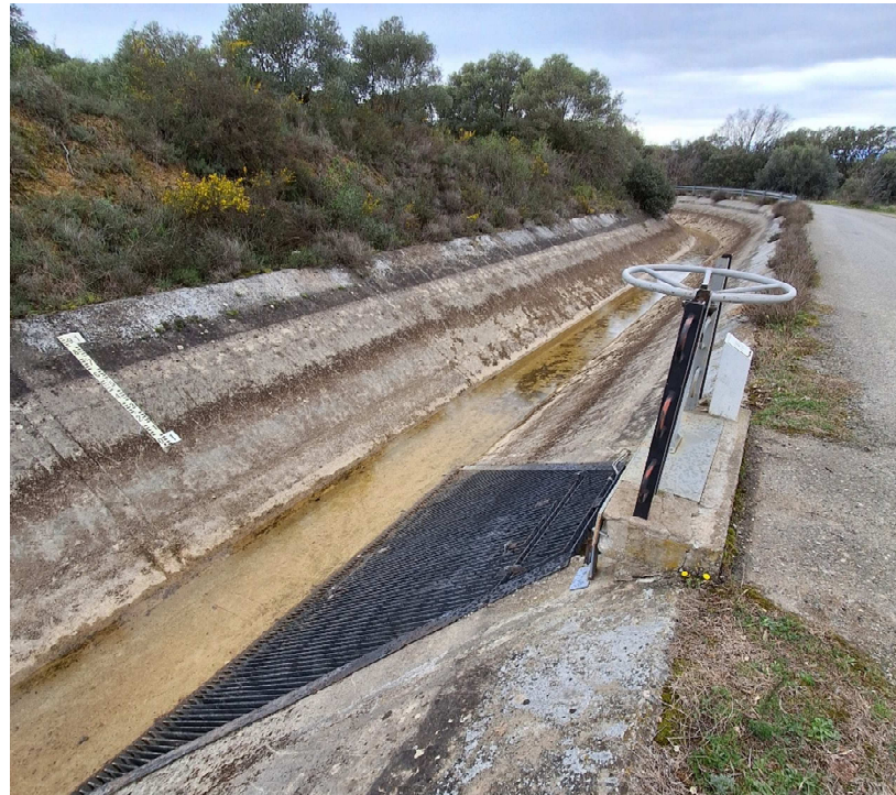
Fotografía 24 Compuerta S-9,520 en la Acequia de Selgua.
