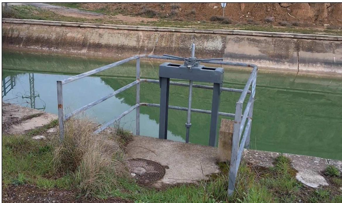
Figura 4. Compuerta actual de la toma lateral C-74,060
