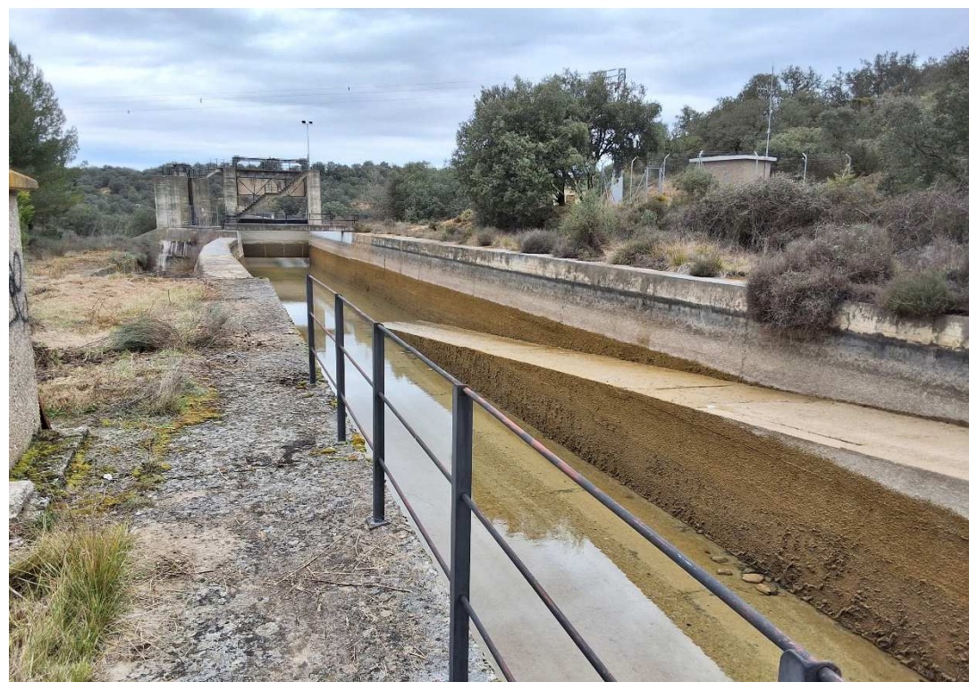
Fotografía 8 Compuerta Iv-0,010 en la Acequia izquierda del Vero. Canal del Cinca.
