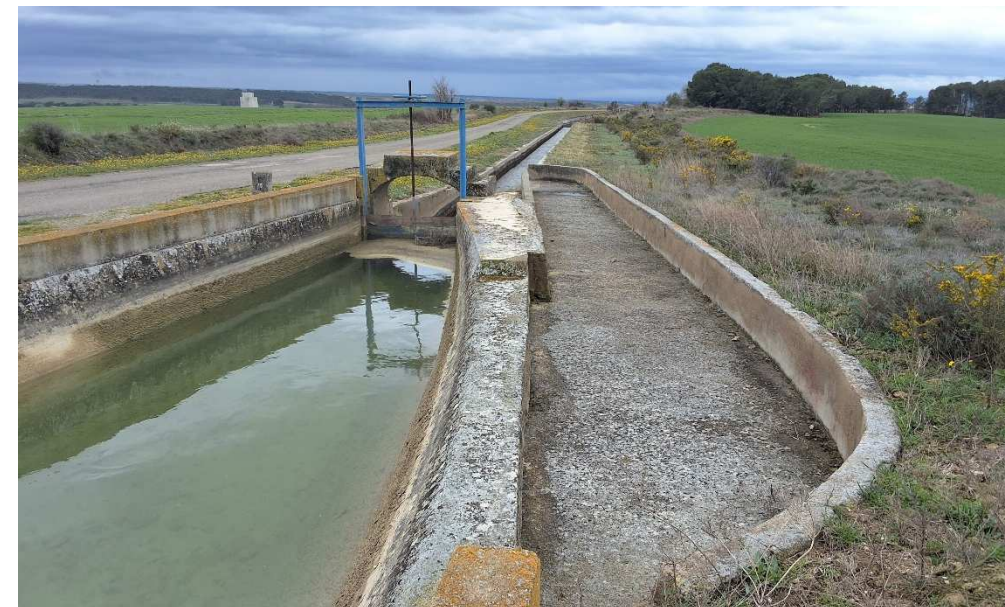
Fotografía 34 Compuerta V-13,593 en la Acequia de La Violada. Aliviadero.
