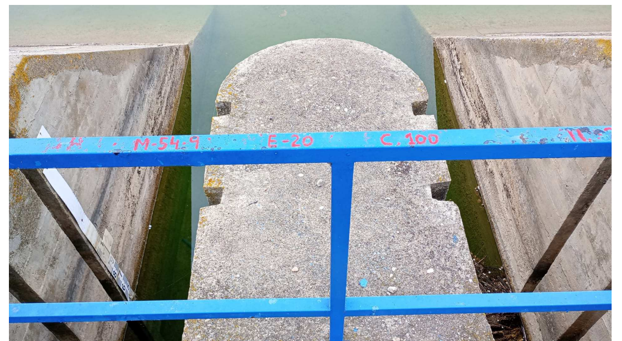
Fotografía 15 Compuerta M-54,960 en el Canal de Monegros.
