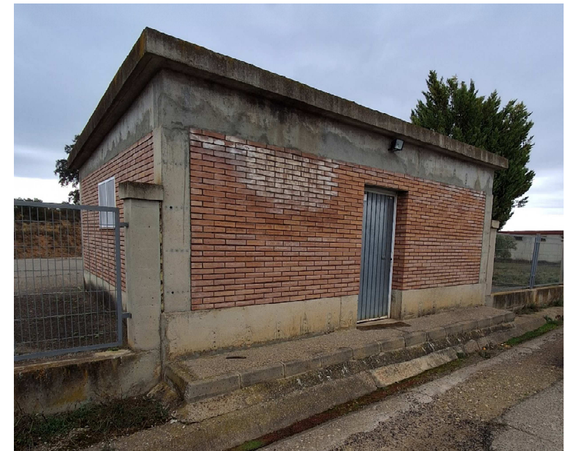
Fotografía 26 Compuerta S-9,520 en la Acequia de Selgua. Edificación de abastecimiento de agua a Barbastro.
