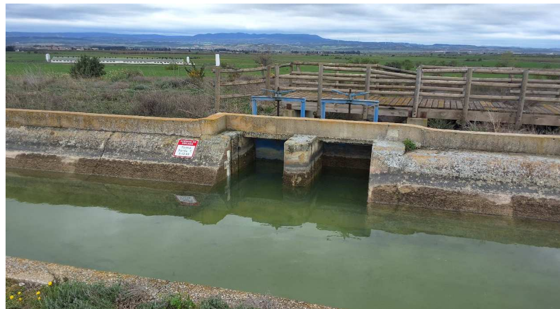
Fotografía 29 Compuerta V-13,593 en la Acequia de La Violada.
