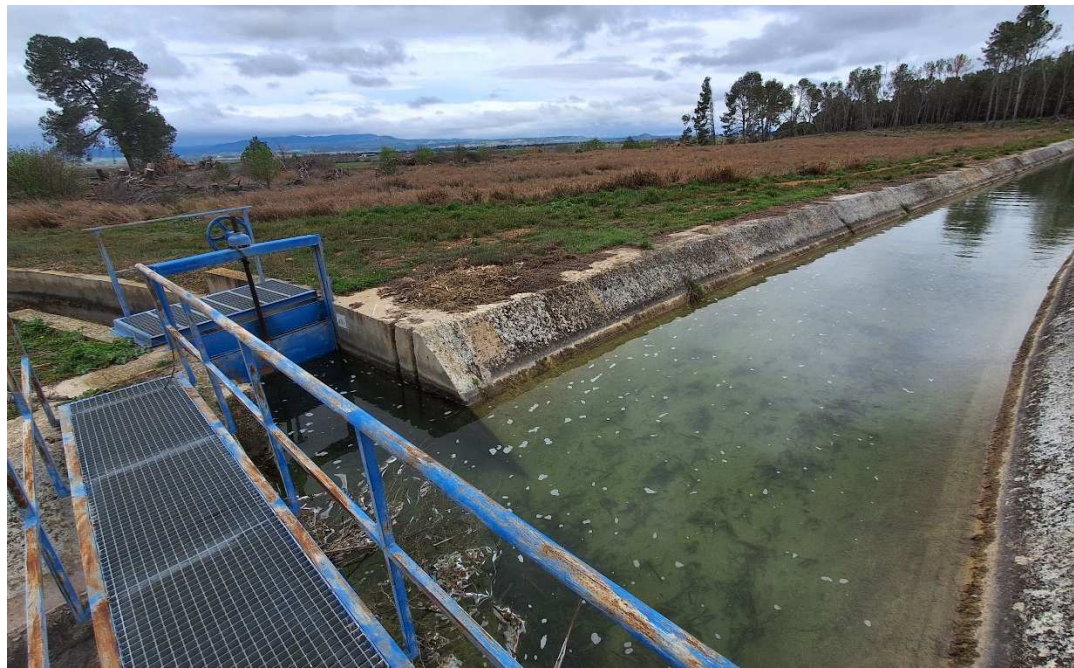
Fotografía 40 Compuerta V-18,088 en la Acequia de La Violada.
