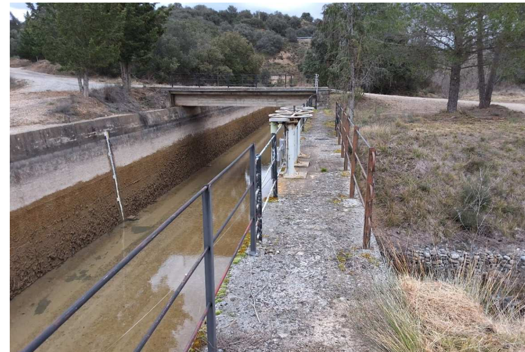
Fotografía 6 Compuerta Iv-0,010 en la Acequia izquierda del Vero.
