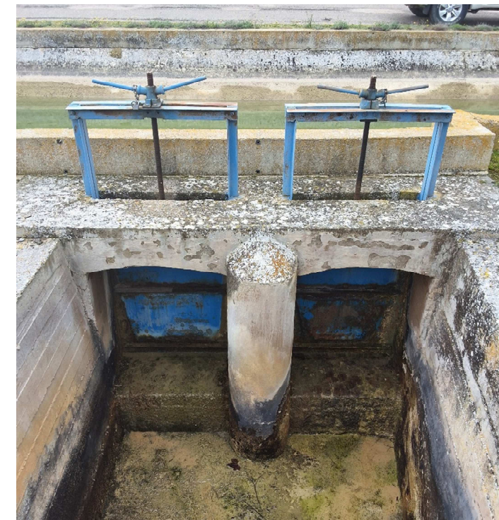
Fotografía 31 Compuerta V-13,593 en la Acequia de La Violada.
