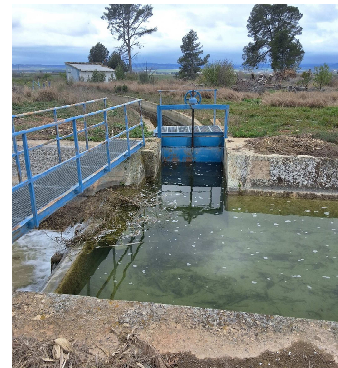
Fotografía 39 Compuerta V-18,088 en la Acequia de La Violada.
