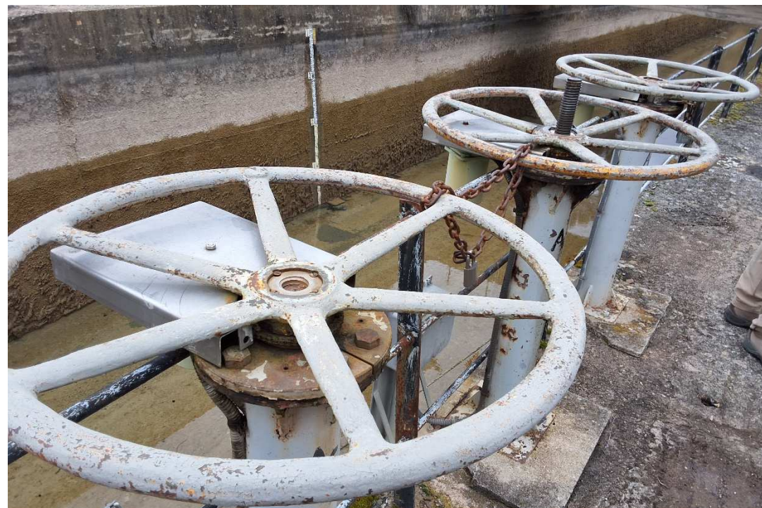
Fotografía 5 Compuerta Iv-0,010 en la Acequia izquierda del Vero.
