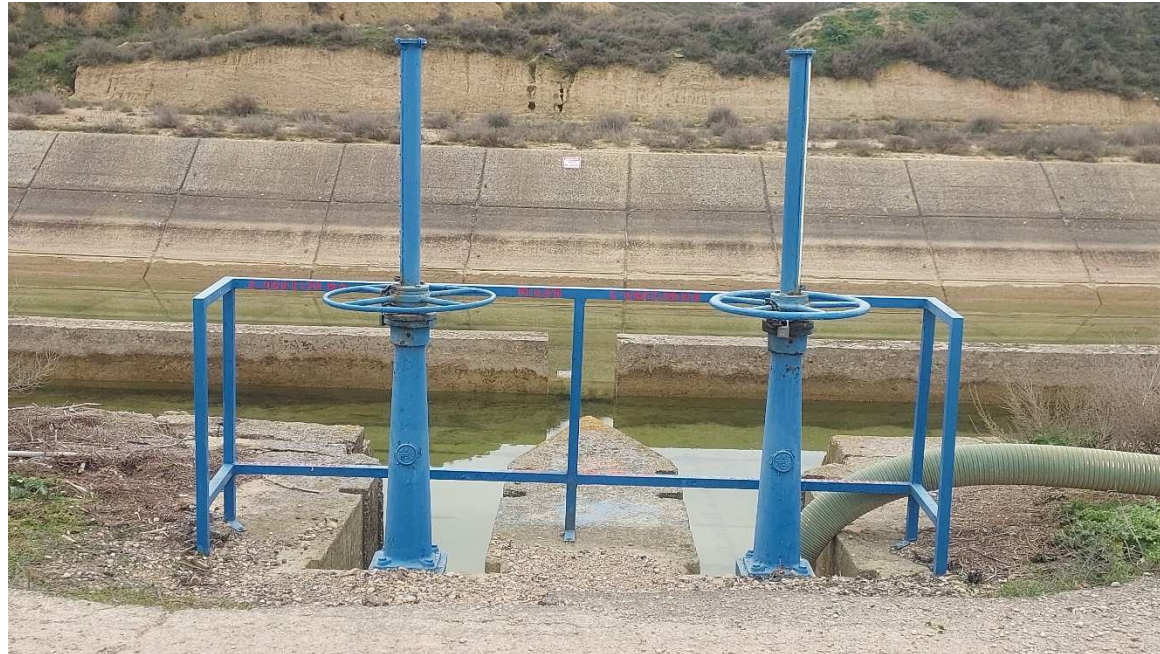
Fotografía 16 Compuerta M-60,085 en el Canal de Monegros.
