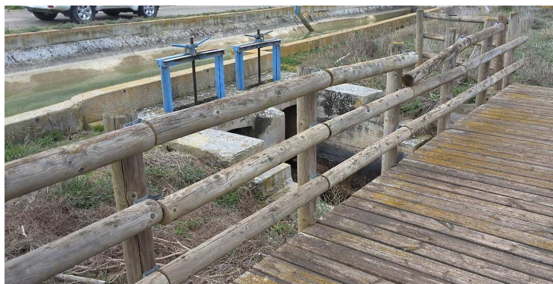
Fotografía 33 Compuerta V-13,593 en la Acequia de La Violada.
