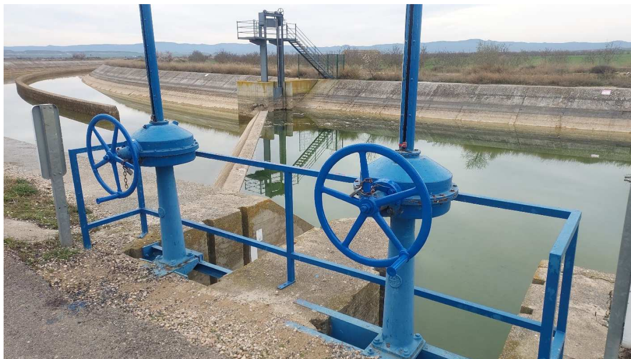
Fotografía 13 Compuerta M-54,960 en el Canal de Monegros.
