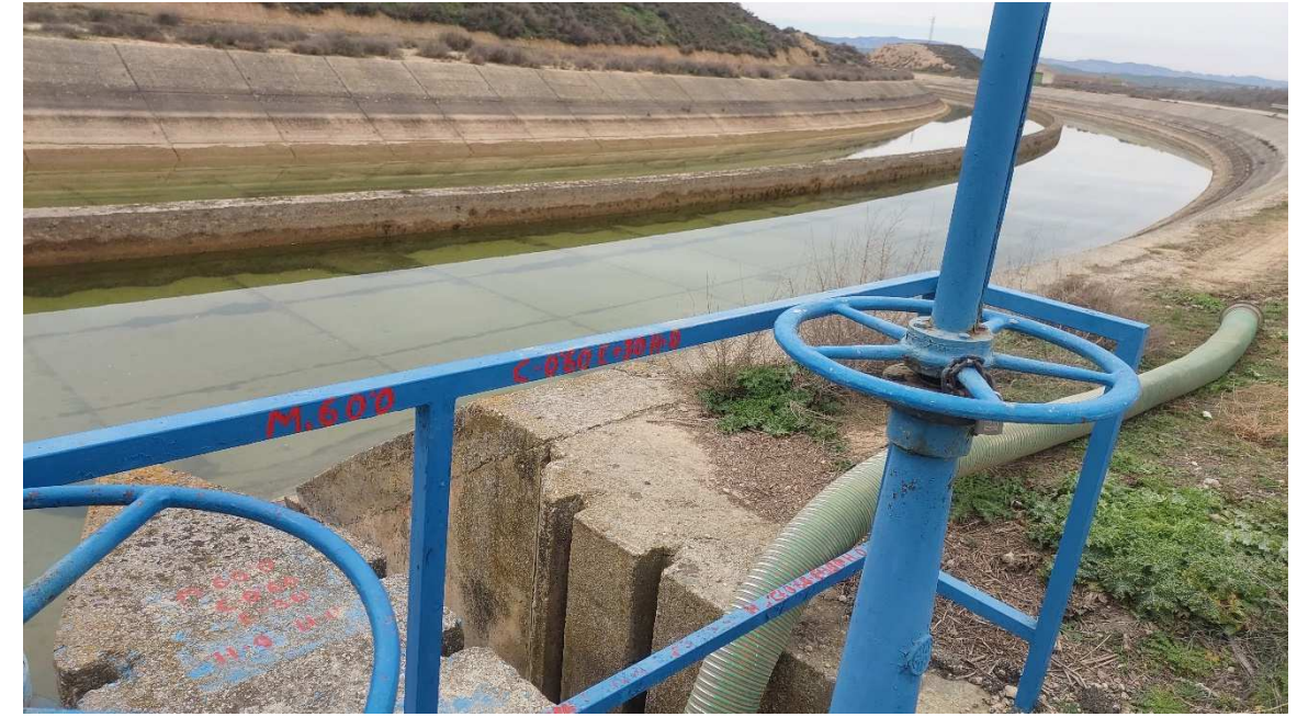
Fotografía 18 Compuerta M-60,085 en el Canal de Monegros.
