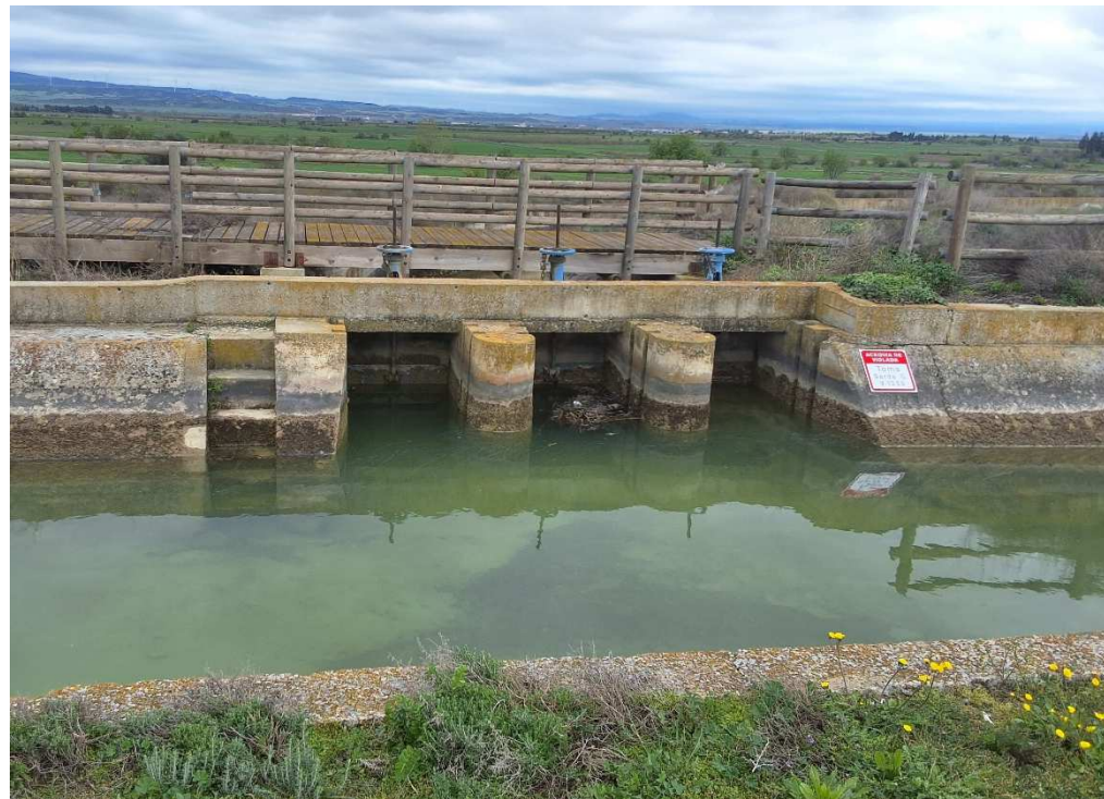
Fotografía 36 Compuerta V-13,584 en la Acequia de La Violada.
