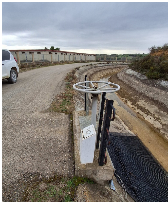
Fotografía 25 Compuerta S-9,520 en la Acequia de Selgua.
