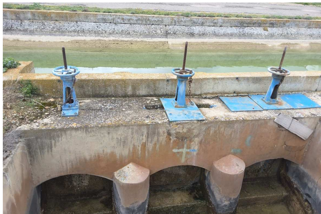
Fotografía 37 Compuerta V-13,584 en la Acequia de La Violada.
