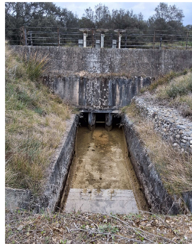
Fotografía 10 Compuerta Iv-0,010 en la Acequia izquierda del Vero.
