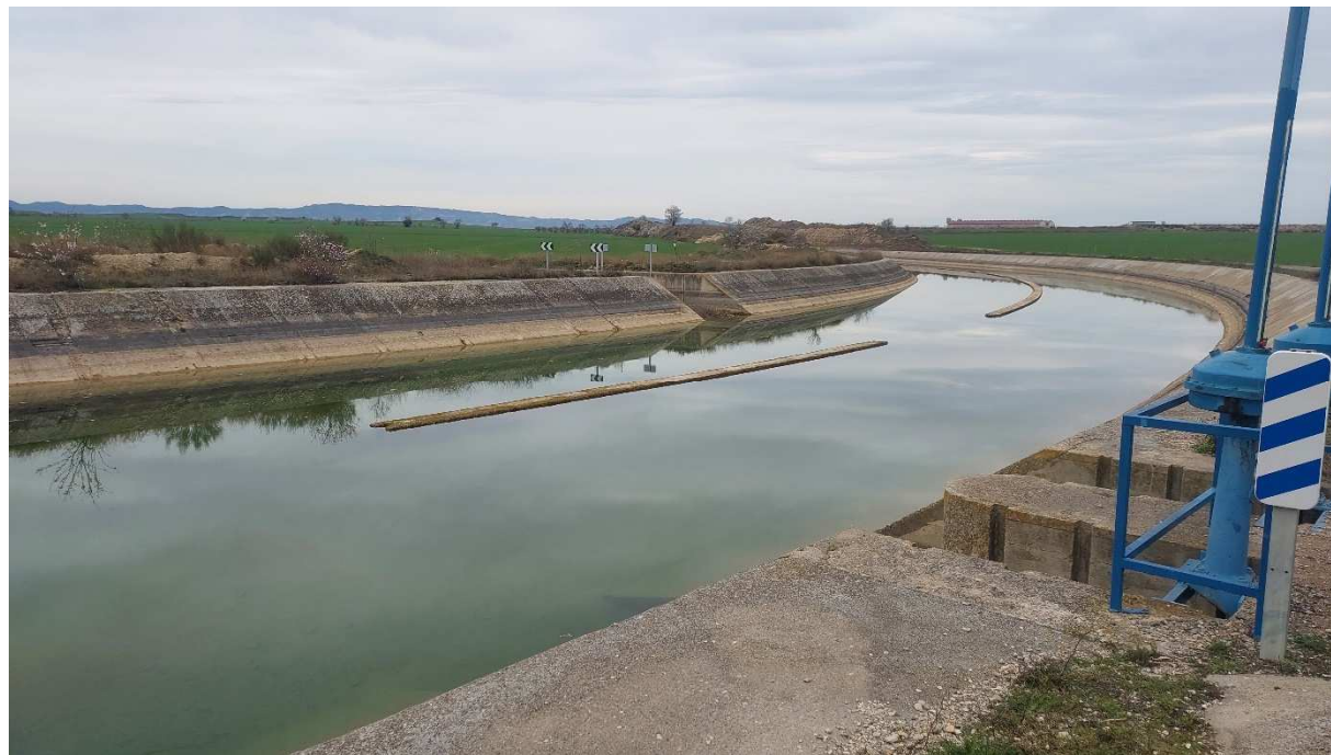
Fotografía 12 Compuerta M-54,960 en el Canal de Monegros.
