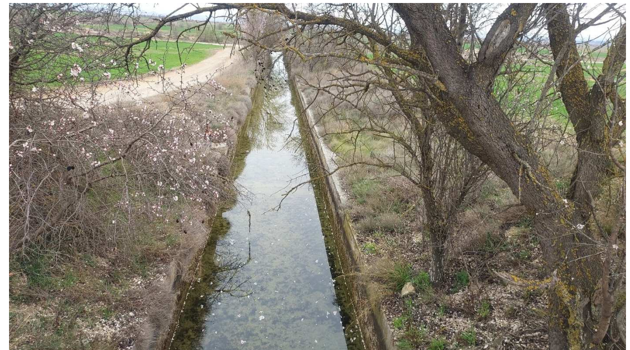
Fotografía 14 Compuerta M-54,960 en el Canal de Monegros. Canal abierto hacia CR Lalueza.
