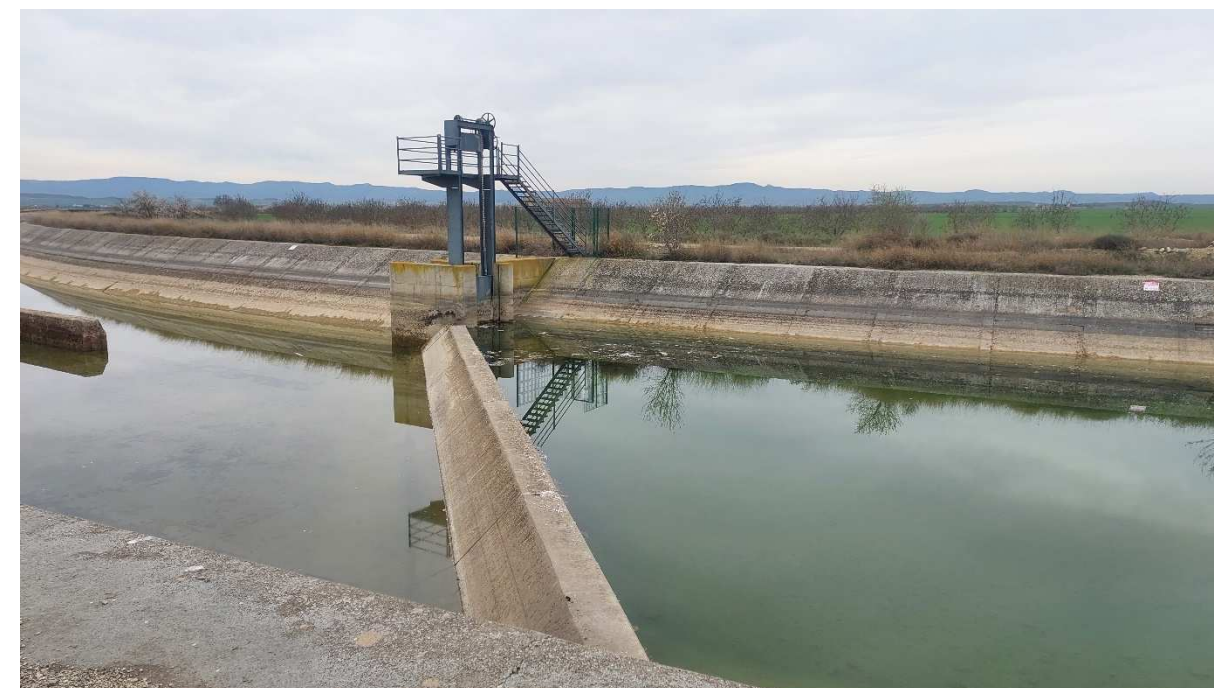
Fotografía 11 Compuerta M-54,960 en el Canal de Monegros. Ataguía del canal.
