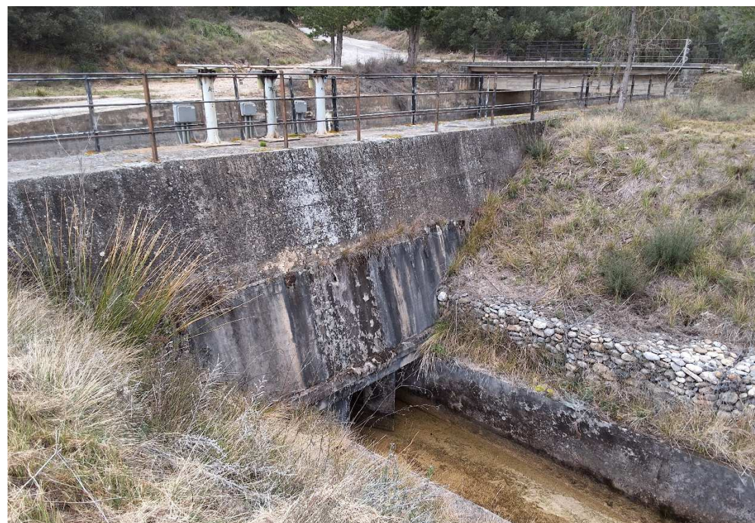
Fotografía 9 Compuerta Iv-0,010 en la Acequia izquierda del Vero. Canal del Cinca.
