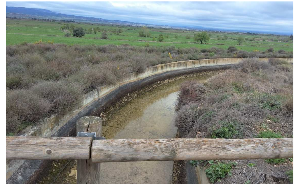
Fotografía 38 Compuerta V-13,584 en la Acequia de La Violada. Canal abierto hacia CR Gurrea (toma sarda-G).
