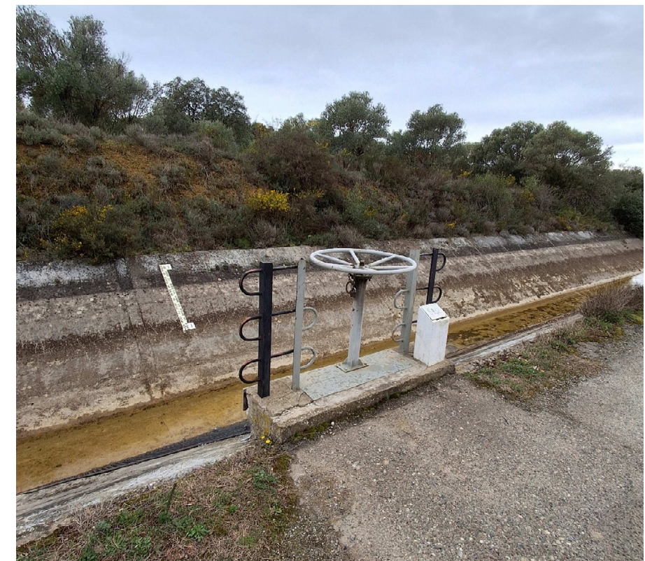
Fotografía 23 Compuerta S-9,520 en la Acequia de Selgua.
