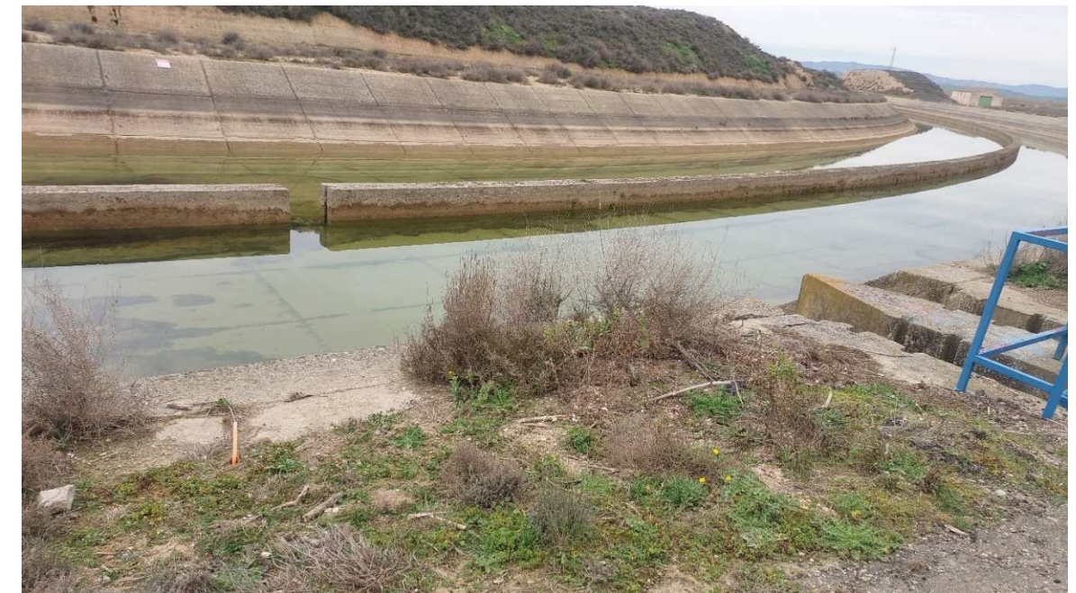
Fotografía 19 Compuerta M-60,085 en el Canal de Monegros.
