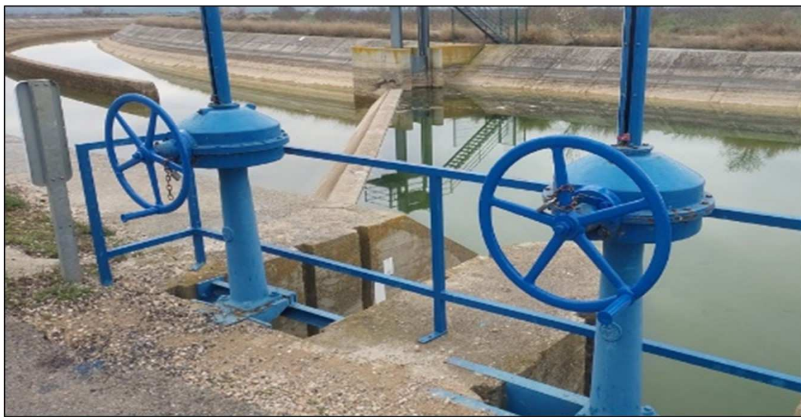
Figura 6. Compuerta actual de la toma lateral M-54,96
