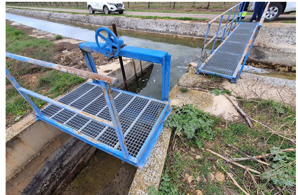
Fotografía 42 Compuerta V-18,088 en la Acequia de La Violada.
