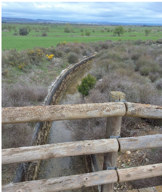
Fotografía 32 Compuerta V-13,593 en la Acequia de La Violada. Canal abierto hacia CR El Temple (toma sarda-T).
