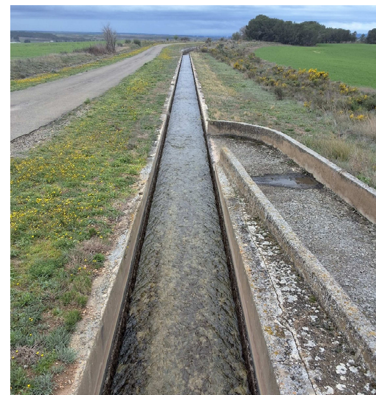
Fotografía 35 Compuerta V-13,593 en la Acequia de La Violada. Aliviadero.
